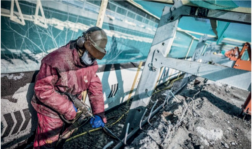
Sillan reunapalkin betonin poistoa vesipiikkaamalla. (Kuva: Delete)
