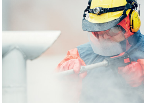
Korkeapainepesu 250 bar:sta ylöspäin yleisimmin 500–1 000 bar. (Kuva: L&T)
