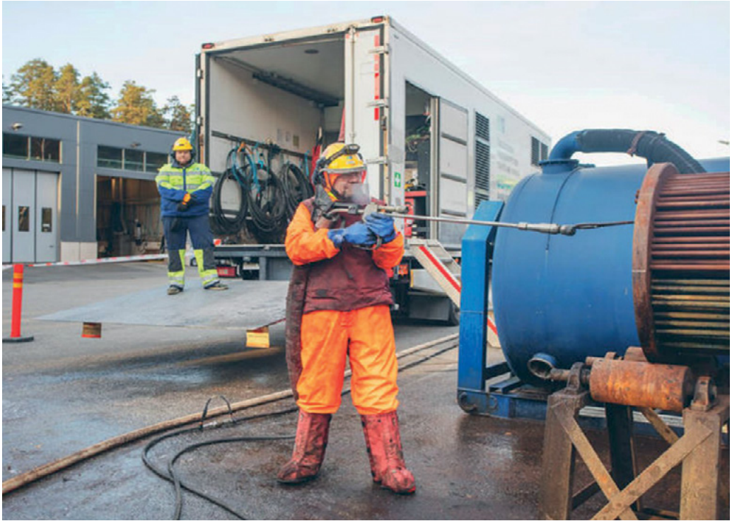
Varmistushenkilö seuraa työn etenemistä. (Kuva: L&T)
