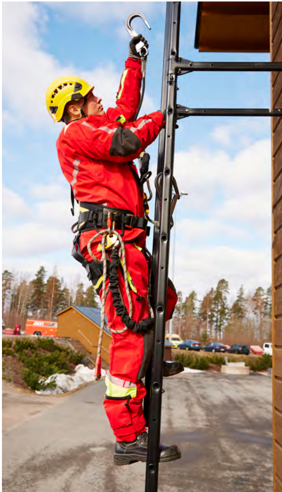
Kuva 93. Y MGO:n toisen koukun tulee olla jatkuvasti kiinnitettynä rakenteissa.
