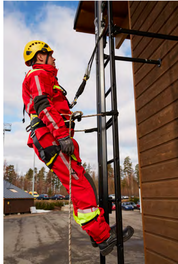
Kuva 37. Työasemointi liitosköydellä.
