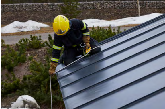
Kuva 70. Työvaran mittaaminen reunan ylitykseen.
