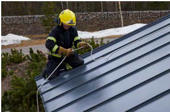
Kuva 71. Työvaran ottaminen reunan ylitykseen.
