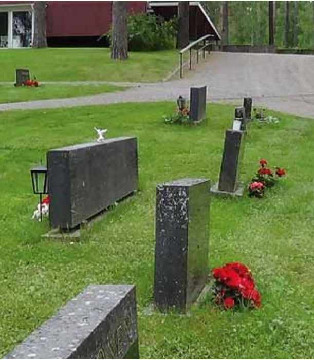
Kallistunut tai heikkokuntoinen hautakivi saattaa aiheuttaa vakavaa vaaraa.
