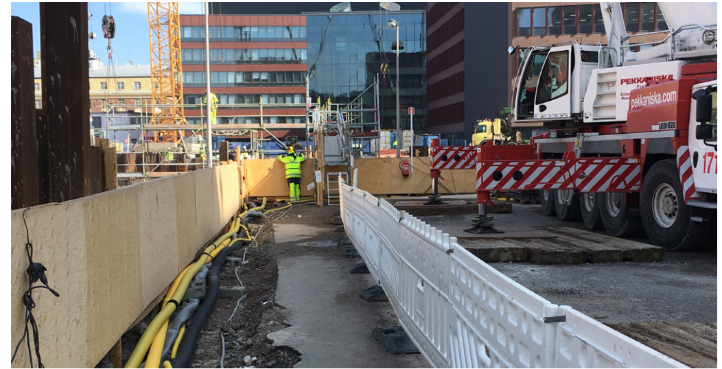
Nostopaikan ja työmaan kulkureitin erottaminen.
