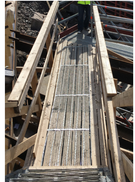
Työmaan sisäiset kulkureitit pitää suunnitella ja niiden kunnossapidosta pitää huolehtia.
