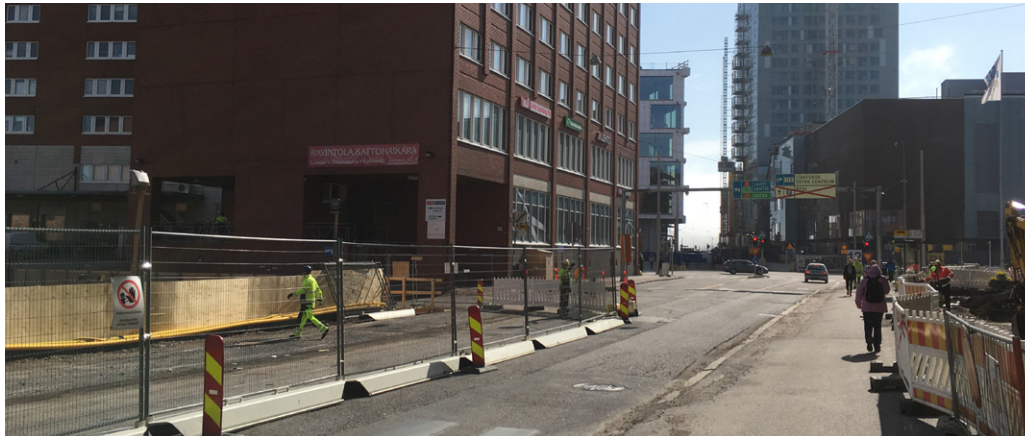
Työmaalla on järjestetty ajoneuvoille läpiajokaista.
