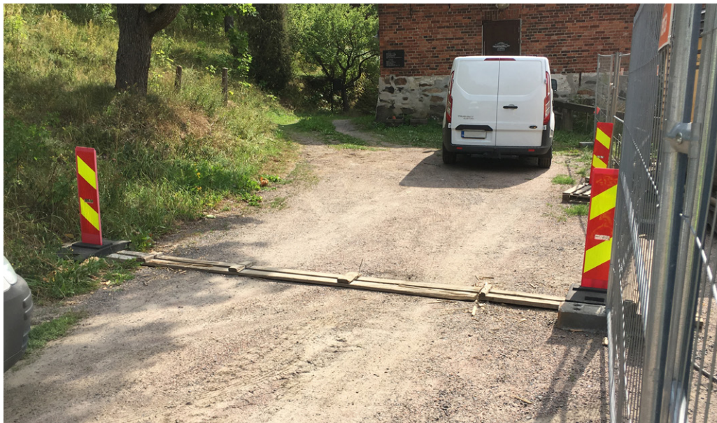
Sähköjohto on turvallisesti merkattu näkyviin ja suojattu laudoin.
