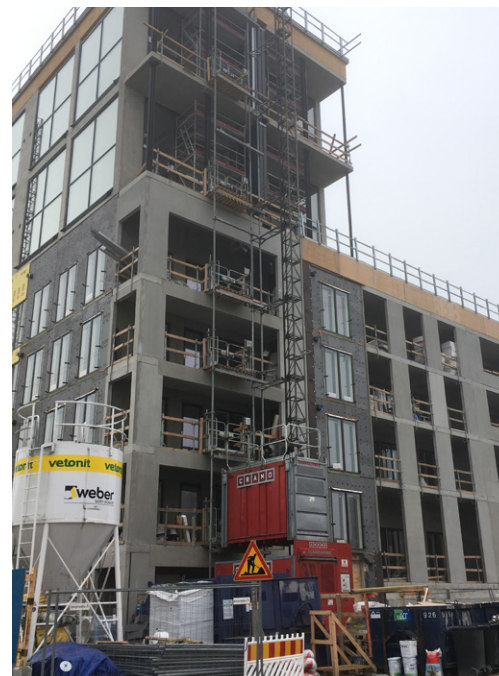
Työmaalla on huomioitu myös materiaalsiirrot rakennushissillä.
