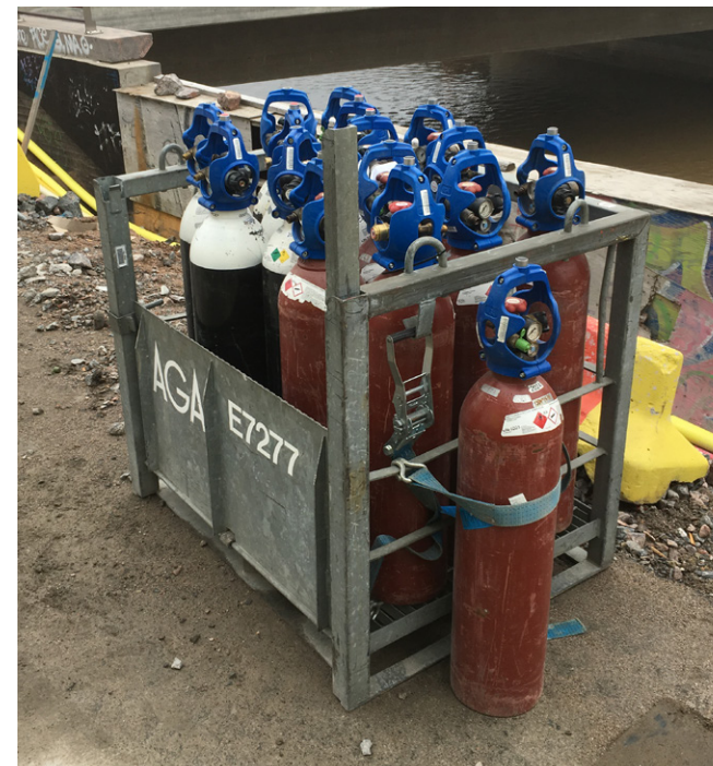
Kaasupullojen säilyttämistä työmaalla.
